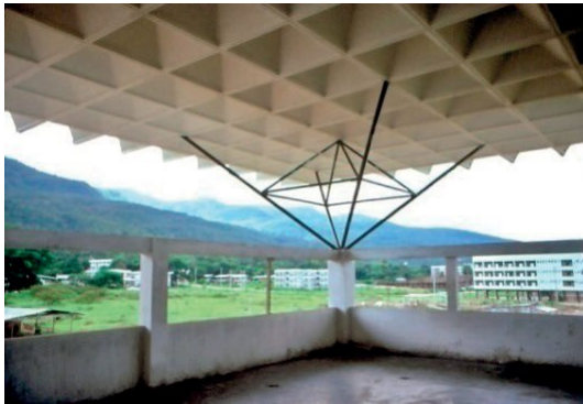
รูปที่ ๖๖ อาคารปฏิบัติการใช้ท่อเหล็กขนาดเส้นผ่านศูนย์กลาง ๕๐.๘ มิลลิเมตร ถ่ายนำหนักหลังคาลงสู่เสาคอนกรีต
