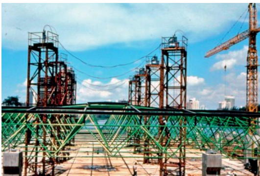
รูปที่ ๔๒ แม่แรงไฮดรอลิก ๘ ตัว ที่ใช้ยก โครง ๓ มิติ ที่ประกอบเสร็จแล้ว และวางบนพื้น พร้อมยกเข้าที่
