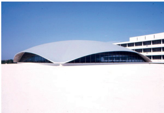
รูปที่ ๒๓ ภายนอกของหลังคาเปลือกบางเสร็จเรียบร้อยแล้ว
