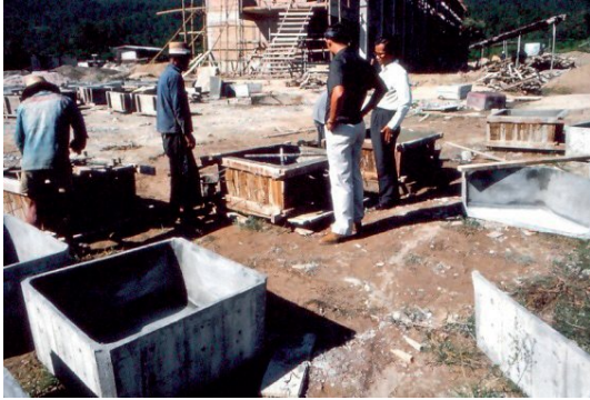
รูปที่ ๔๘ แบบรูปกระทงทำด้วยมอร์ตาร์
