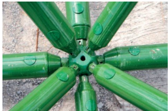
รูปที่ ๔๐ จุดต่อรวมขององค์อาคาร
