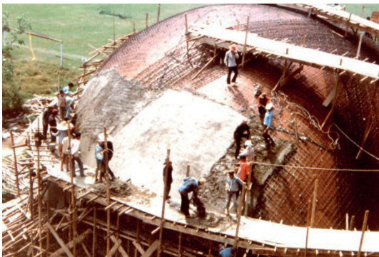
รูปที่ ๒๗ ขณะเทคอนกรีต
