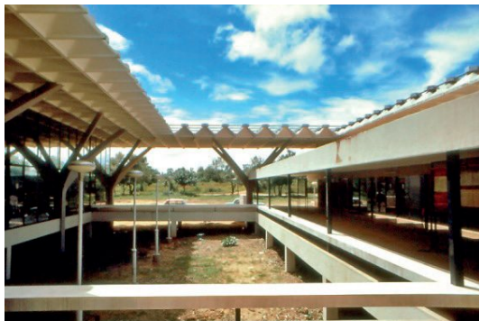
รูปที่ ๖๑ หลังคาทั้งหมดเป็นชนิดคอนกรีตหล่อสำเร็จ
