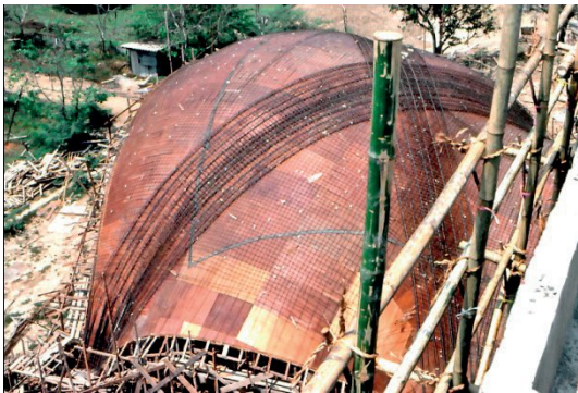
รูปที่ ๒๖ หลังจากปูไม้แบบและวางเหล็กเสริมหลักแล้ว
