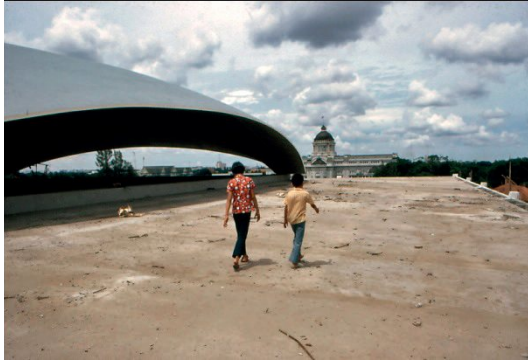
รูปที่ ๒๒ หลังจากถอดไม้แบบและไม้ค้ำยันออกแล้ว
