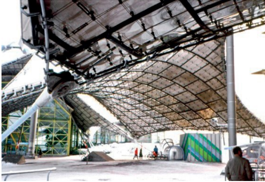
รูปที่ ๕๕ การเสริมเหล็กบริเวณหัวเสา ซึ่งทำด้วยท่อเหล็กขนาดใหญ่
