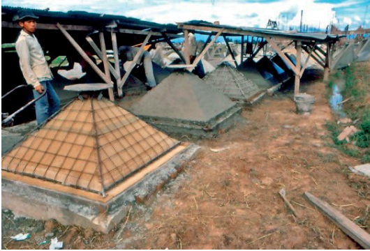
รูปที่ ๒๒ การหล่อชิ้นส่วนหลังคาเป็นรูปพีระมิดกลาง
