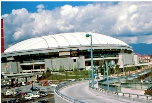
รูปที่ ๕๗ สนามกีฬาในร่มที่ British Columbia, ประเทศแคนาดา เป็นโครงสร้างชนิดอัดลม
