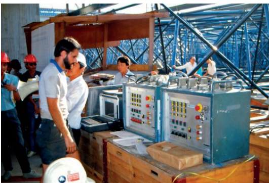
รูปที่ ๔๒ แม่แรงไฮดรอลิก ๘ ตัว ที่ใช้ยก โครง ๓ มิติ ที่ประกอบเสร็จแล้ว และวางบนพื้น พร้อมยกเข้าที่
