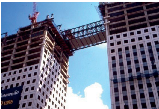
รูปที่ ๓๔ การยกโครงข้อหมุน ๑ ชุดเข้าที่
