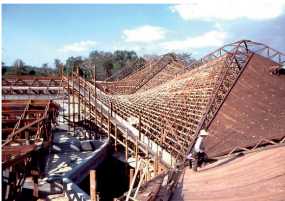
รูปที่ ๑๖ การวางไม้คร่าว ไม้แบบ ตลอดจนการผูกเหล็กเสริม
