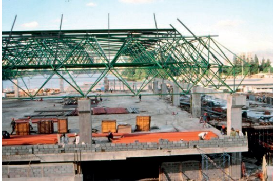
รูปที่ ๔๔ โครงหลังคา ๓ มิติ ที่วางอยู่บนเสาจริง เรียบร้อยแล้ว
