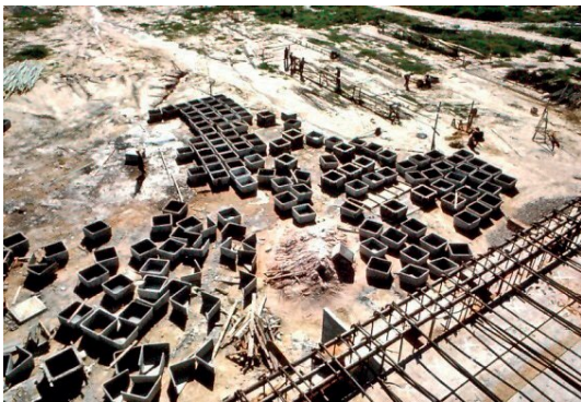
รูปที่ ๔๙ เมื่อสร้างถึงชั้นดาดฟ้า แบบรูปกระทงก็เสร็จครบพอดี
