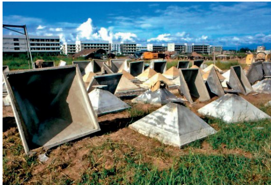
รูปที่ ๒๓ ชิ้นส่วนหลังคาที่หล่อไว้ตั้งแต่เริ่มงานก่อสร้าง พร้อมทั้งจะยกไปติดตั้ง
