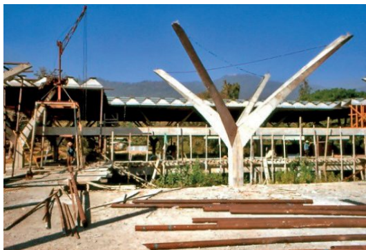
รูปที่ ๒๔ เสา ๑ ต้น แยกออกเป็น ๔ แฉก
