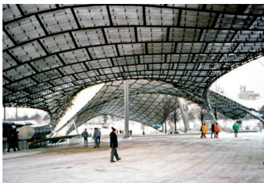
รูปที่ ๕๔ ภายใต้หลังคามีโครงเหล็ก
