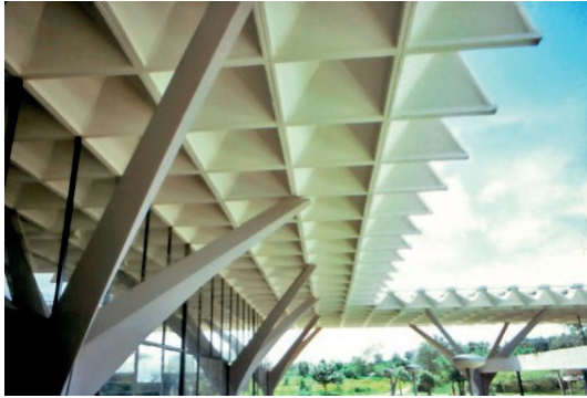
รูปที่ ๖๕ ปลายเสาฝั่งเหล็กขนาด ๒๕ x ๒๕ มิลลิเมตร เพื่อรองรับหลังคา
