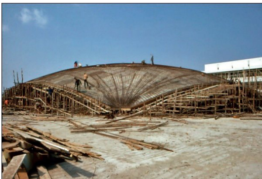
รูปที่ ๒๑ การเสริมเหล็กหลังคาเสร็จสิ้นพร้อมเทคอนกรีต
